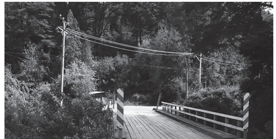
Cableado de alta tensión de RP Global, en la entrada hacia Tranquil
